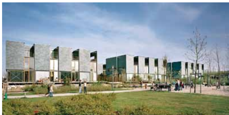
Holzbau in Reih und Glied: Die äußerst flexiblen Grundrisse dieser sechs mal vier Reihenhäuser wurden in Mischbauweise errichtet
