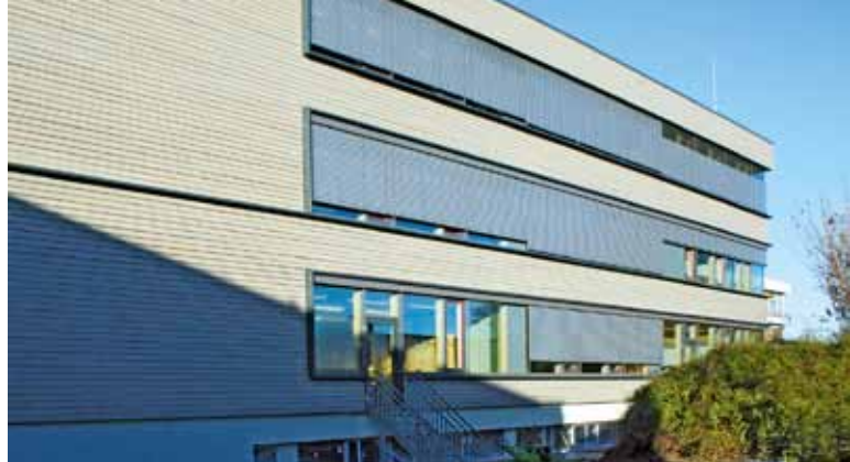
TES Energyfacade: So sehen die vorgefertigten, selbsttragenden Holztafelelemente nach der Montage auf die bestehende Bausubstanz aus
